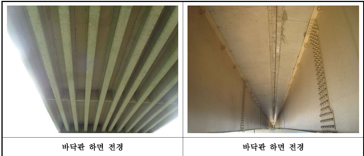
【사진 10.3.2】 바닥판하면 전경
