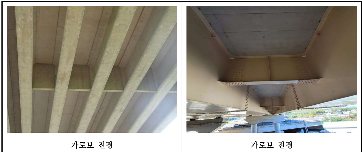
【사진 10.3.6】 가로보 및 세로보 전경
