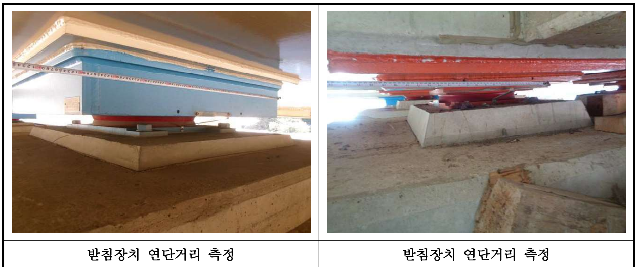
【사진 10.3.14】 교량받침장치 연단거리측정
