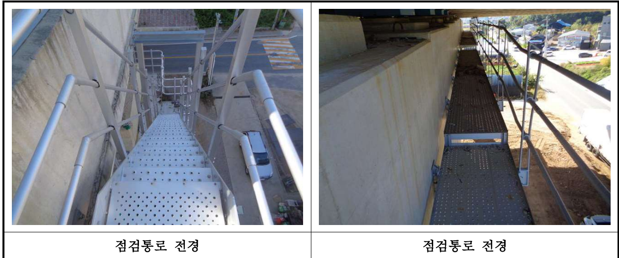
【사진 10.3.25】 교량 점검시설 전경
