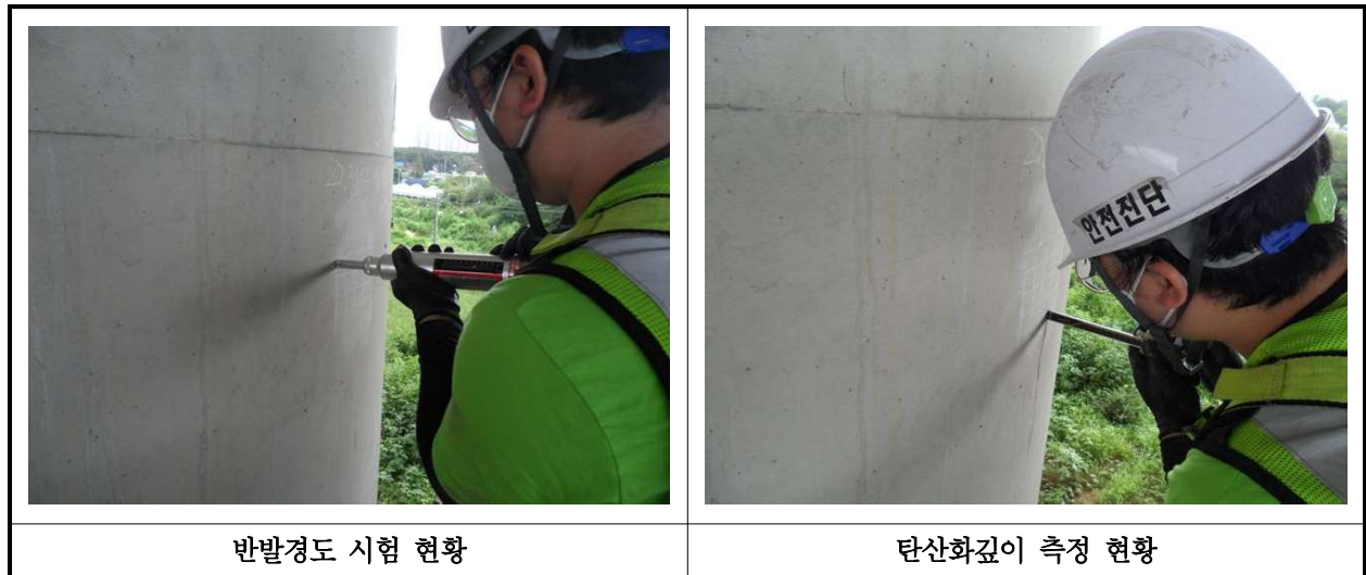
【사진 10.4.1】 콘크리트 내구성조사 현황
