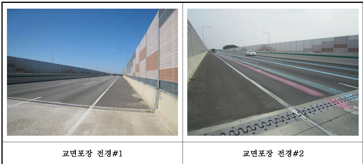
【사진 10.3.19】 교면포장 전경
