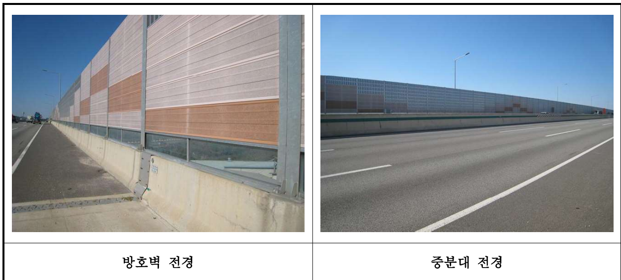
【사진 10.3.23】 방호벽 및 중앙분리대 전경
