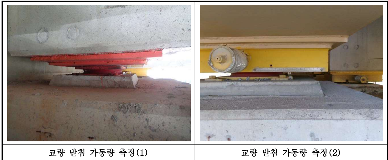
【사진 10.3.15】 교량받침 이동량 측정
