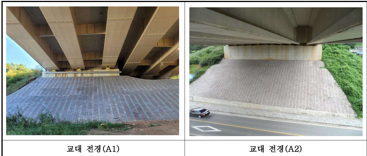
【사진 10.3.8】 교대 전경
