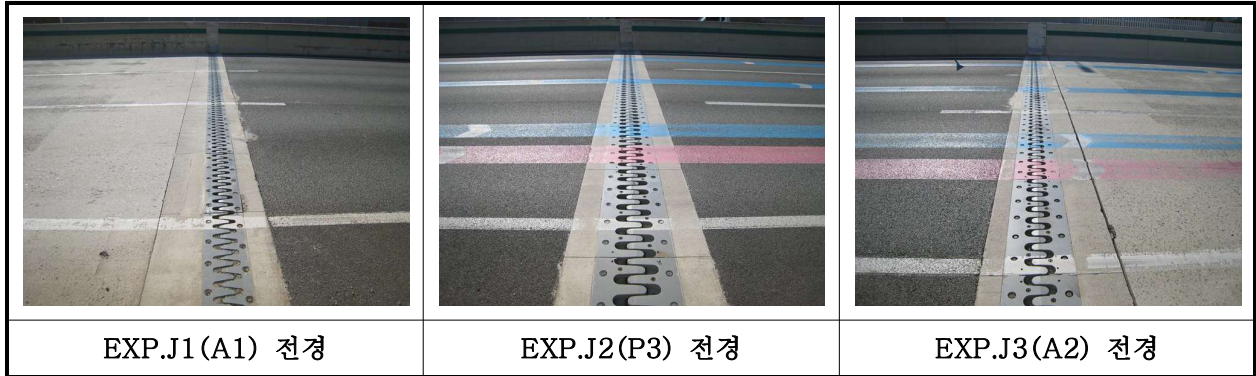
【사진 10.3.16】 신축이음장치 전경
