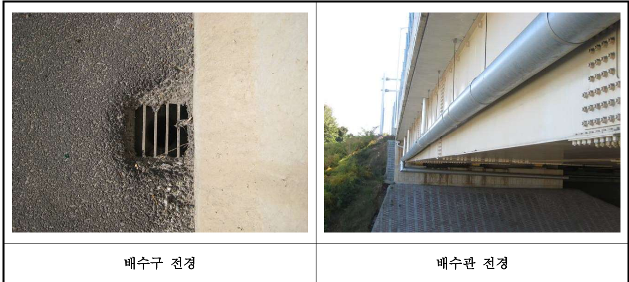
【사진 10.3.21】 배수시설 전경
