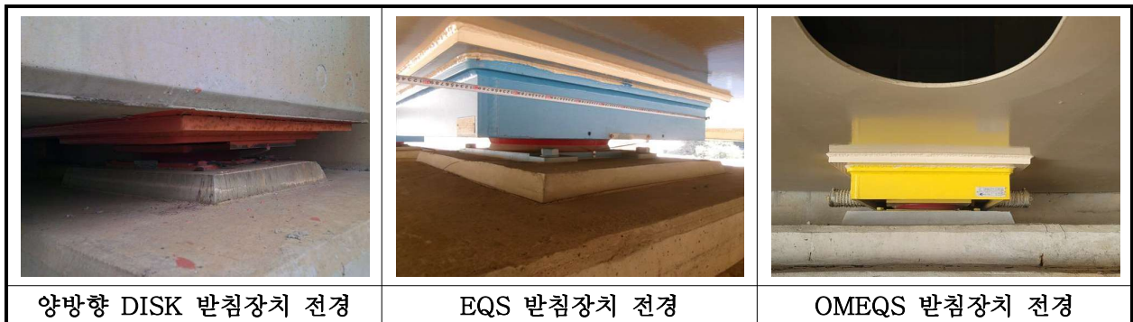
【사진 10.3.12】 교량받침 전경
